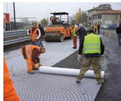
Posa geocomposito **Bitutex® Composite** alla rottura della mano di attacco
